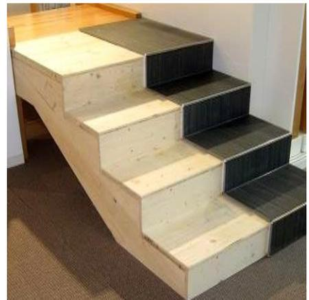
Rivestimento e finitura della scala grezza con piastrelle o parquet (se previsto da capitolato), a scelta dai campionari WOLF. La parte inferiore della scala viene verniciata. Se la scala non viene eseguita tra due pareti è prevista una ringhiera in faggio con orditura verticale in elementi metallici o elementi in faggio.
